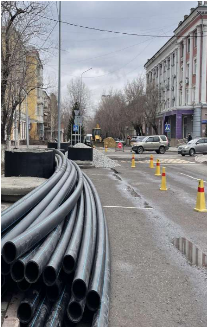
Капитальный ремонт водопроводных сетей на ул. Костенко
