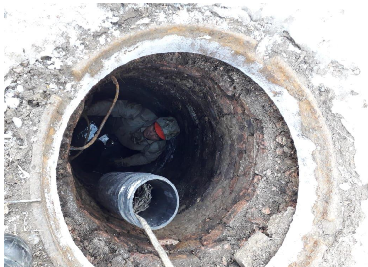
Монтаж модулей (труб)
