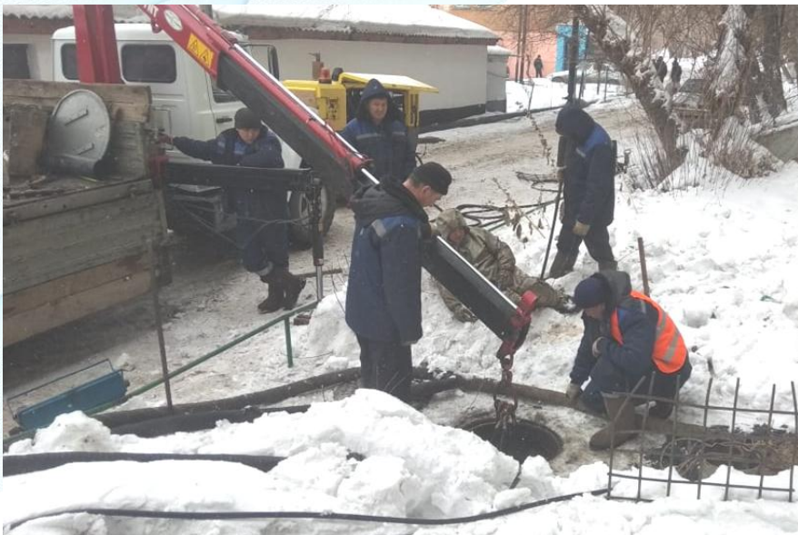
Установка разрушителя в колодец
