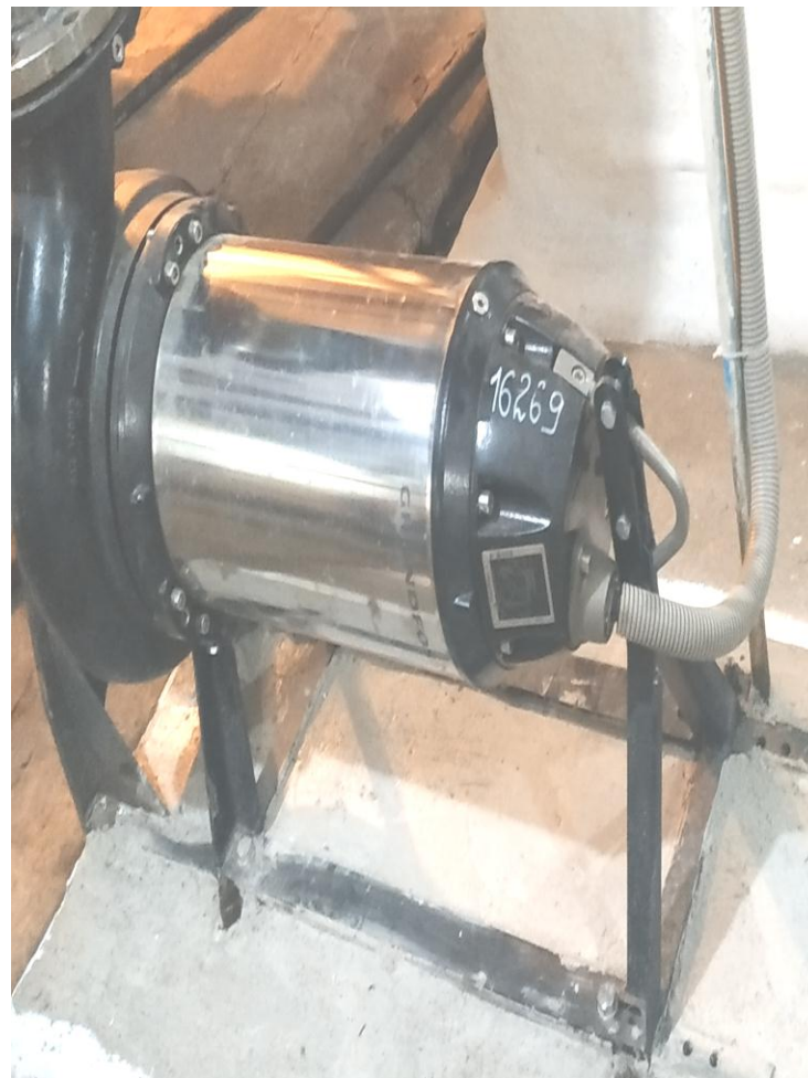
Насосы канализационные мощностью 20 кВт и 50 кВт
