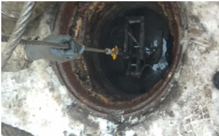
Установка разрушителя в колодец
